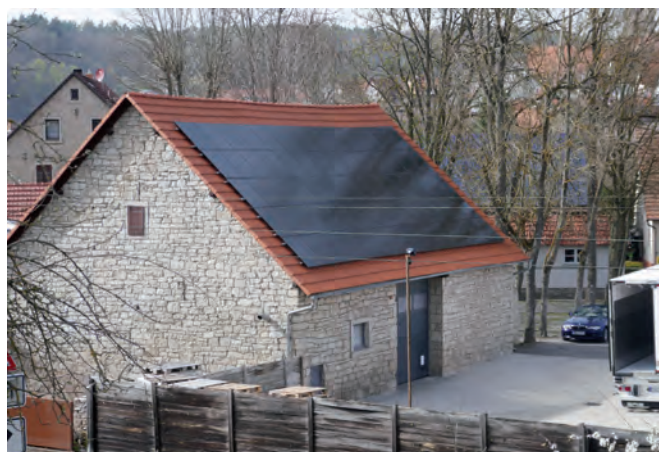
Beispiel für eine ruhige Dachfläche mit PV - Modulen
