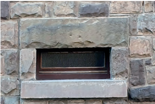
Fenster mit Gewände im Natursteinsockel
