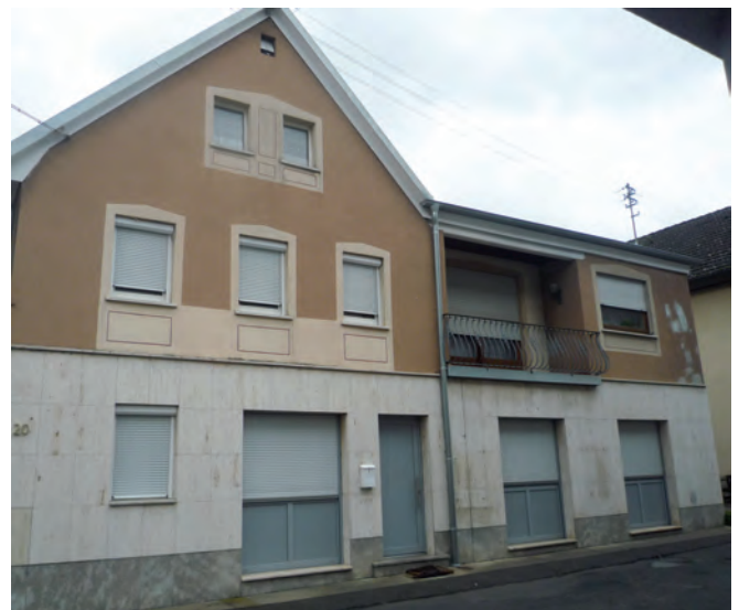
Negativbeispiel: nicht abgestimmte, unpassende Fassadengestaltung
