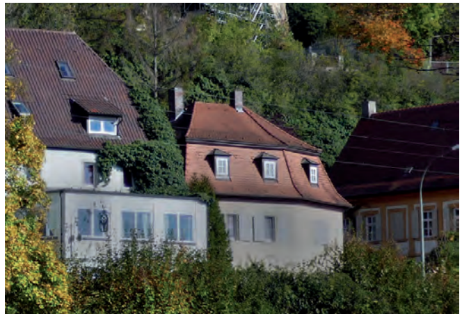
Walmdachgaube an historischem Gebäude
