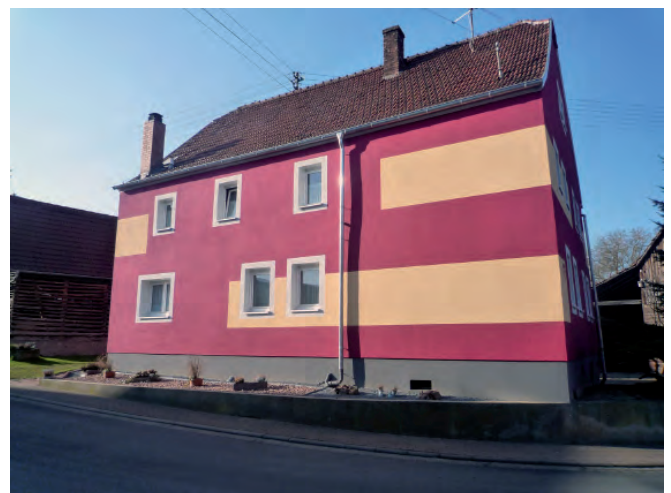
Negativbeispiel: unpassende Farbgestaltung, zu moderne Gestaltungselemente prägen die Fassade
