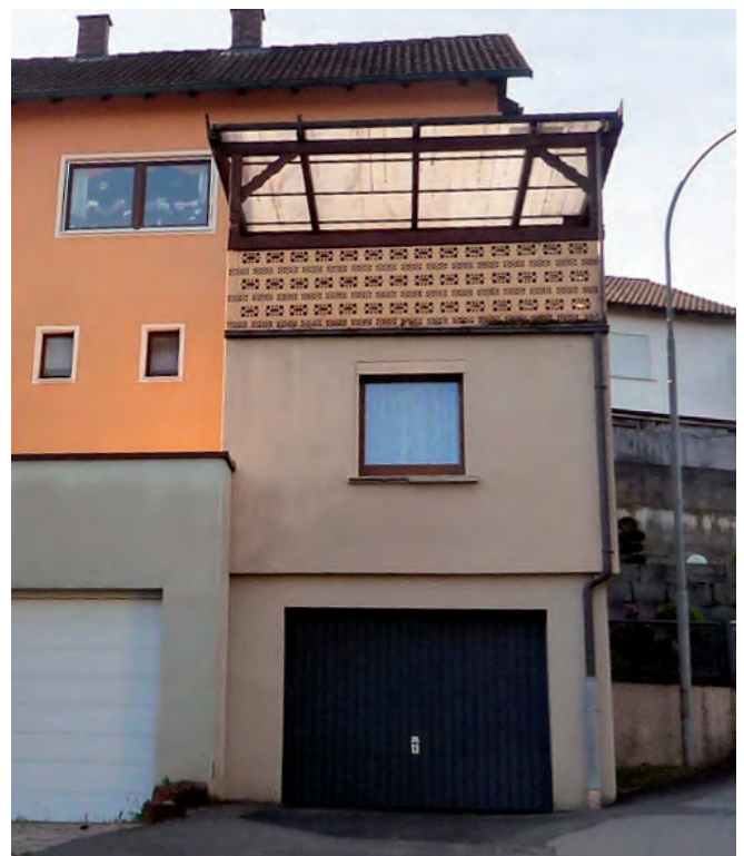
Negativbeispiel: unpassende Balkonbrüstung und Kunststoffüberdachung
