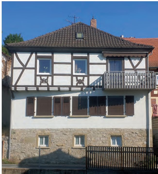
Nachträglich angebauter Balkon in Fachwerkfassade
