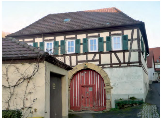
Walmdach an historischem Gebäude
