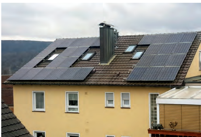
Negativbeispiel: Ungeordnete PV Anlagen verunklaren Dachlandschaft
