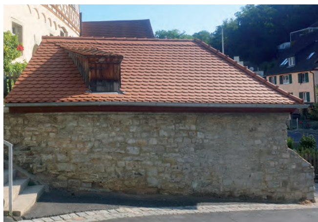
Nebengebäude in Naturstein
