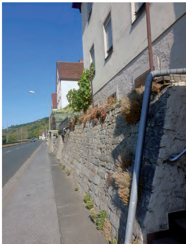
Grenzmauern an der Mainleite
