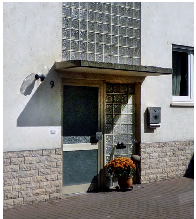
Negativbeispiel: Glasbausteine und strukturiertes Glas prägen den Eingangsbereich
